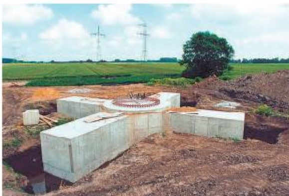
Ainsi commence la mort d'un paysage : la construction des fondations d'une éolienne.
